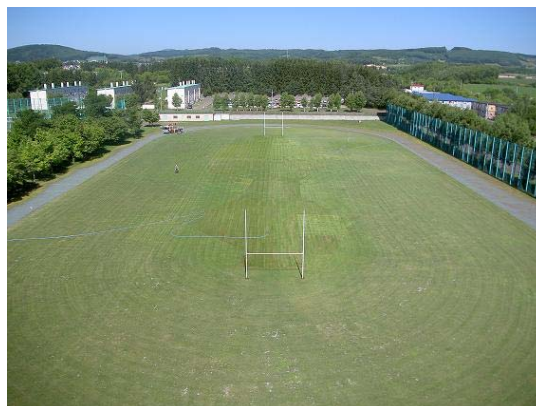
芝補修工事中の陸上競技場
